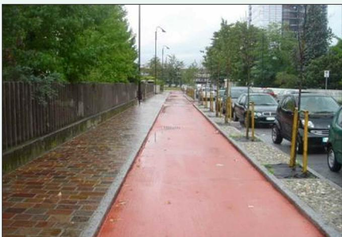
Figura 18 - La pista ciclabile in malta fotocatalitica rossa in strato sottile, Segrate (MI)
